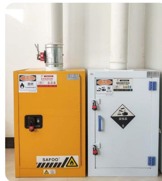
图3.6 易燃液体化学品柜和腐蚀性化学品柜
