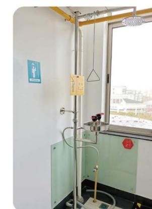
图4.4 集成的应急喷淋和洗眼器
