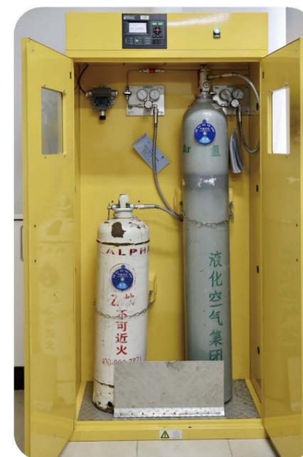
图3.7 气瓶固定在直立位置，存放在阴凉、通风良好的地方
