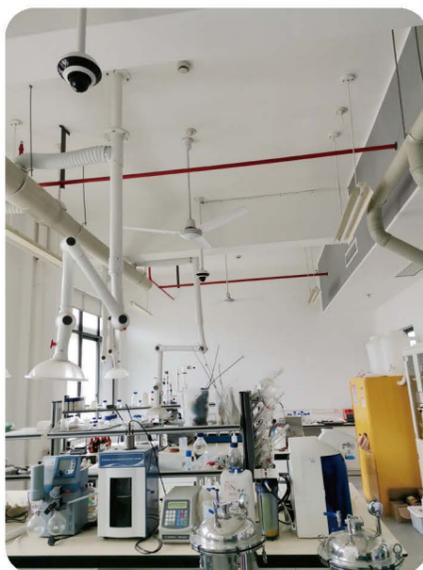
图3.10 可将柔性臂捕获罩放置在靠近污染源的位置
